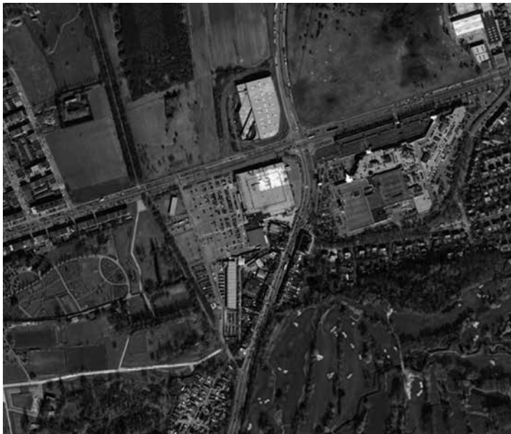
Afbeelding 2: situering Makro site gelegen op de grens van Deurne en Wijnegem ( www.geopunt.be , 9 april 2024)
