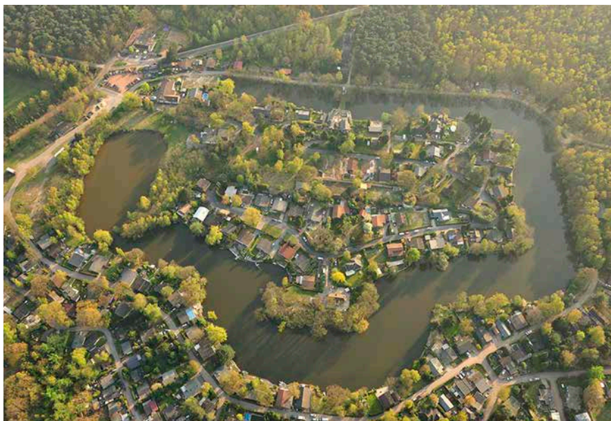
Figuur 5.1 Luchtfoto Fort 's Gravenwezel.
